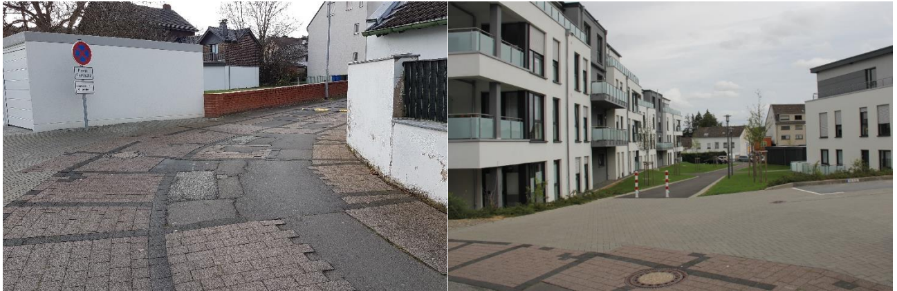
Abb. 79: Bestandsfotos der Gartenstraße Quelle: Planungsgruppe MWM 2020
