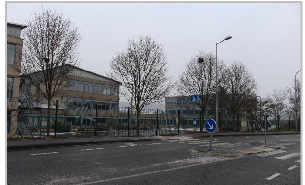
Abb. 48: Schulzentrum Mechnich Quelle: Planungsgruppe MWM 2019
