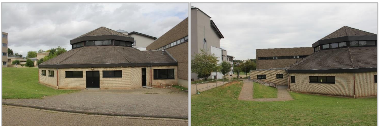
Abb. 68: Bestandsfotos Oktogon mit als Mehrzweckhalle genutzte Dreifachturnhalle Quelle: Planungsgruppe MWM 2020
